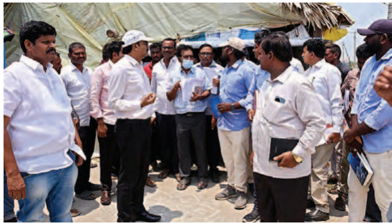
శనివారం పేదచర్లలోని జానమ్మ కాలనీ లోతుబ్బలో ఇంటి నిర్మాణాల పురోగతిని తేల్చుకుంటున్న పరిశీలన చేసిన కలెక్టర్ ఎం.వేణుగోపాల్ రెడ్డి (గుంటూరు-ప్రభాతవార్త ప్రతినిధి)
